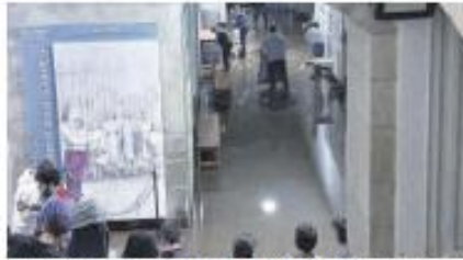
Inundación que sufrió en la planta baja el IES Rosalía de Castro / CICERO
